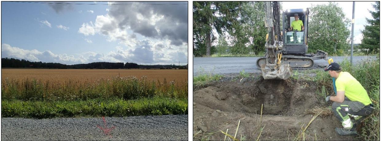
Vasemmalla Tuiskulantien eteläpuolista pellonreunaa, johon tehtiin tunkkauskuoppa. Oikealla kaivetaan Tunkkauskuoppaa Katinalantien eteläpäähän länsipuolelle tien pientareelle ja pellon reunaan.
