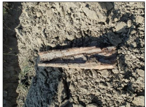
Savisen pellon vanhimpia salaojajärjestelmiä, puisia kouruja, todettiin muutamassa kohdassa.
