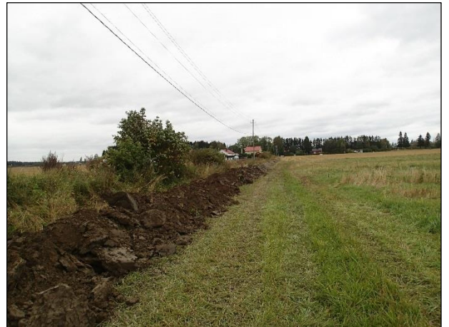
Maakaapeliojan eteläpäätä pellolla, ilmalinjan oikealla puolella. Vasemmalla ennen kaivamista ja oikealla kaivettuna. Kuvattu Kommilantien suunnasta.
