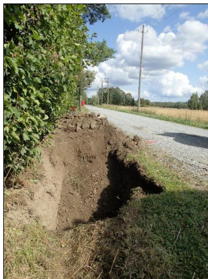
Vasemmalla Kauksaarentien eteläpuolelle tien penkkaan ja pellon laitaa kaivettu tunkkauskuoppa. Oikealla Tuiskulantien pohjoispuolen talon edustalle kaivettu tunkkauskuoppa.
