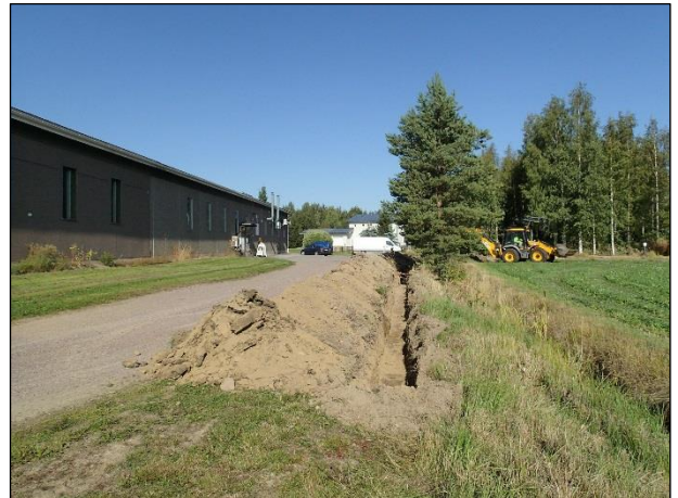
Vasemmalla maakaapeliojan reittiä pihamaan laidalla. Oikealla oja kaivettuna.
